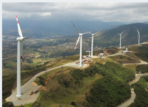
Parc éolien de Villonaco en Équateur 53
